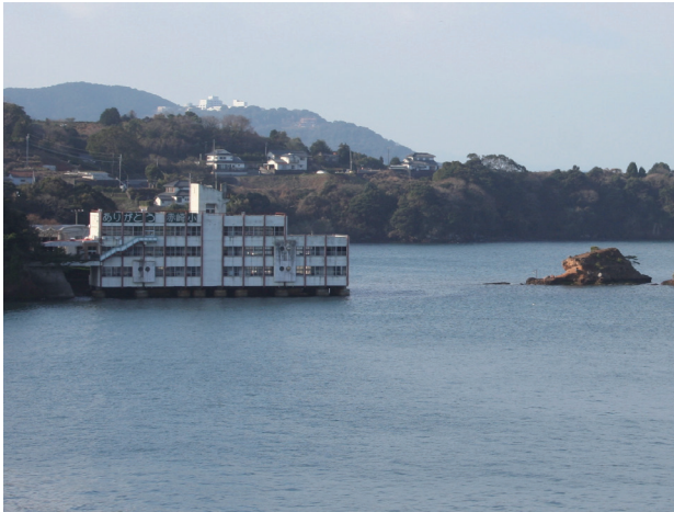
旧津奈木町立赤崎小学校
