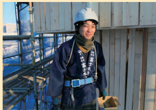
工事も大詰めで作業も慣れてきた アートコンストラクター
