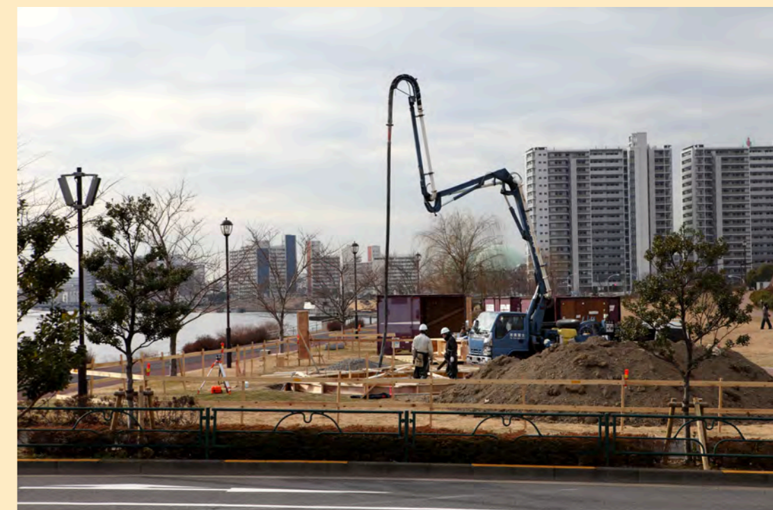
生コンクリート流し込み
