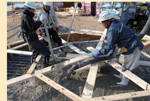
型枠に生コンクリートを流し込む
