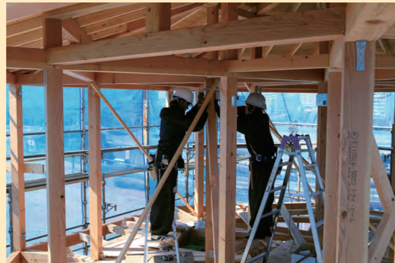
2.26, 3.5 組み立て Construction
