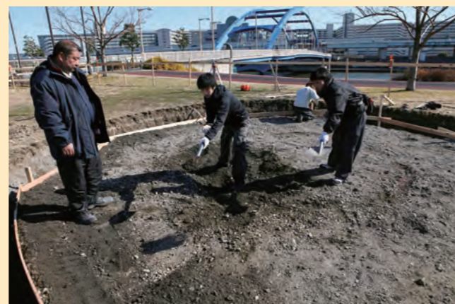
1.24-2.7 基礎工事 Ground Work
