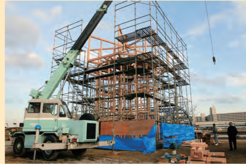
2.16,17 組み立て Construction
