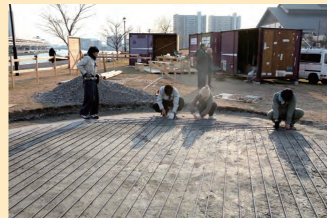
基礎工事・鉄筋骨組み
