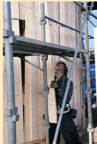
アートコンストラクターによる外壁工事
