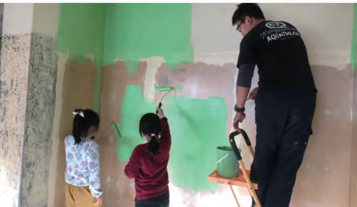
12月25日 くと放送室をつくるためのペンキ塗り
